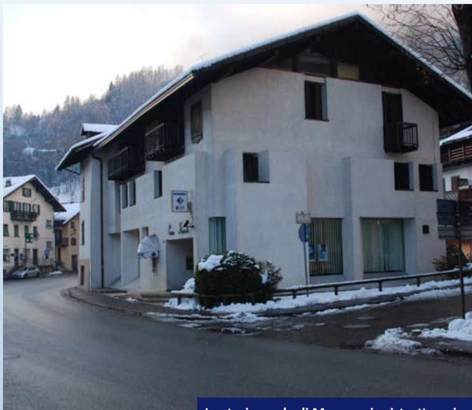
La storica sede di Mezzano in ristrutturazione
